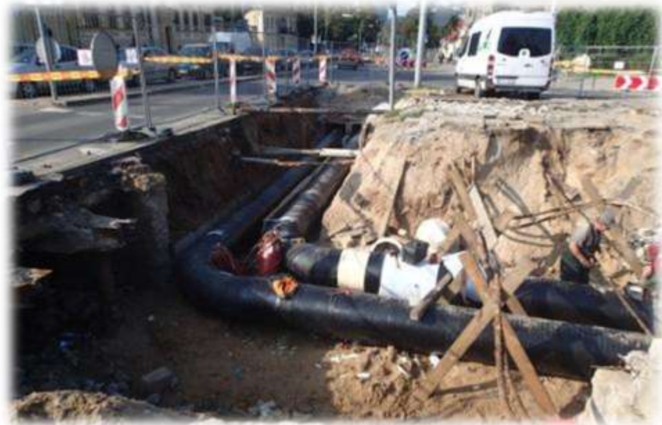
Šiluminės trasos rekonstrukcija Basanavičiaus g-vė.
